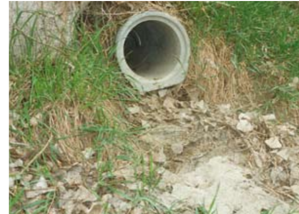
Harte Arbeit, wenn ein Einstich gemacht werden muss!
