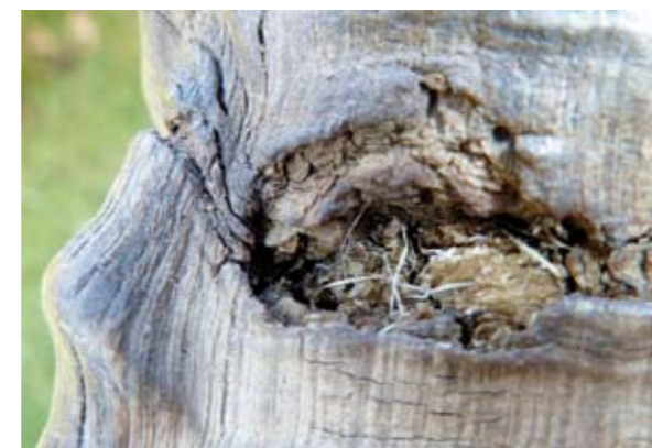
Horndefekt im Bereich eines Jahresringes
